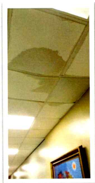
PLAFONES AFECTADOS POR LA FILTRACION
