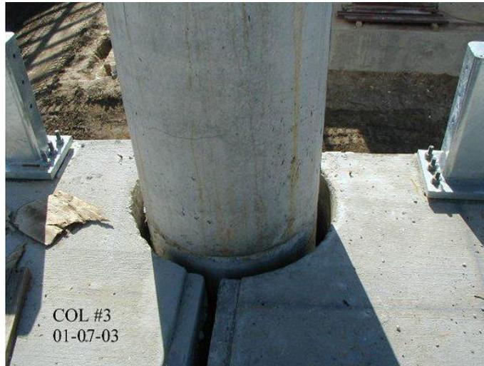
2. Extienda el material de las juntas de expansión, a toda la profundidad del elemento a vaciar, poniendo la parte superior del material de relleno de la junta por debajo de la superficie terminada.
