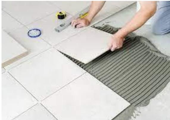
**Ilustración 3.** Imágenes de referencias de terminación de pisos con cerámicas.
