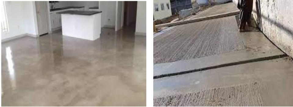
**Ilustración 4.** Imágenes de referencias de terminación de pisos en cemento pulido para interiores y cemento frotado y violinado para exteriores.
