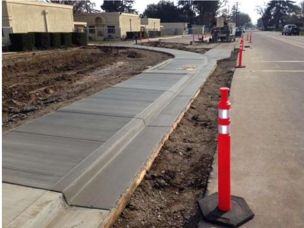
**D. CONTENES:** Los contenes son estructuras con sección transversal especificada en planos. Serán de hormigón simple o armado, según lo indicado en planos. El hormigón a utilizar será premezclado (de planta), con una resistencia mínima a la compresión ( $f'c$ ) de 210 kg/cm<sup>2</sup>, o según lo indicado en planos. Tendrán una terminación pulida, y, en algunos casos, un rayado transversal con escobillón (ver planos arquitectónicos).
