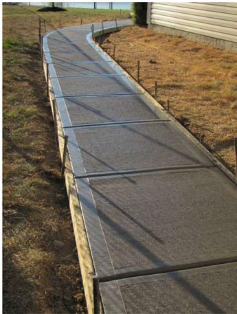
F. No remueva las guarderas hasta después de 24 horas de haber colocado el concreto. Después de remover los moldes, limpie los terminales de las juntas y resane cualquier área conteniendo oquedades o "cucarachas" de importancia secundaria. Remueva y reemplace las áreas o secciones con defectos inaceptables, y que a juicio del Supervisor deban ser reemplazadas.
