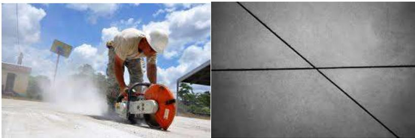
C. Construya juntas en bordillos, contenes y canales, insertando herramientas con hojas de acero de 3 mm (1/8 pulg) de espesor, y que se ajusten a la sección transversal de los indicados bordillos, contenes y canales.
