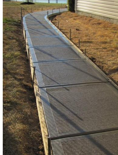
No remueva las guarderas hasta después de 24 horas de haber colocado el concreto. Después de remover los moldes, limpie los terminales de las juntas y resane cualquier área conteniendo oquedades o "cucarachas" de importancia secundaria. Remueva y reemplace las áreas o secciones con defectos inaceptables, y que a juicio del Supervisor deban ser reemplazadas.
