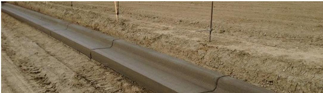
premezclado (de planta), con una resistencia mínima a la compresión ( $f'c$ ) de 210 kg/cm<sup>2</sup>, o según lo indicado en planos. Tendrán una terminación pulida, y, en algunos casos, un rayado transversal con escobillón (ver planos arquitectónicos).
